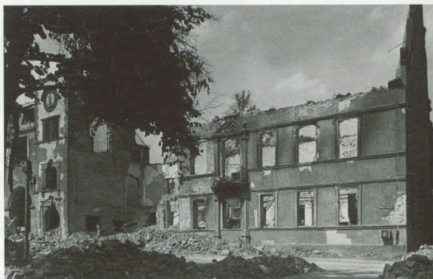
Abb. 60: Rathausbau v. Seidls an der Hagenstraße, Juni 1945
