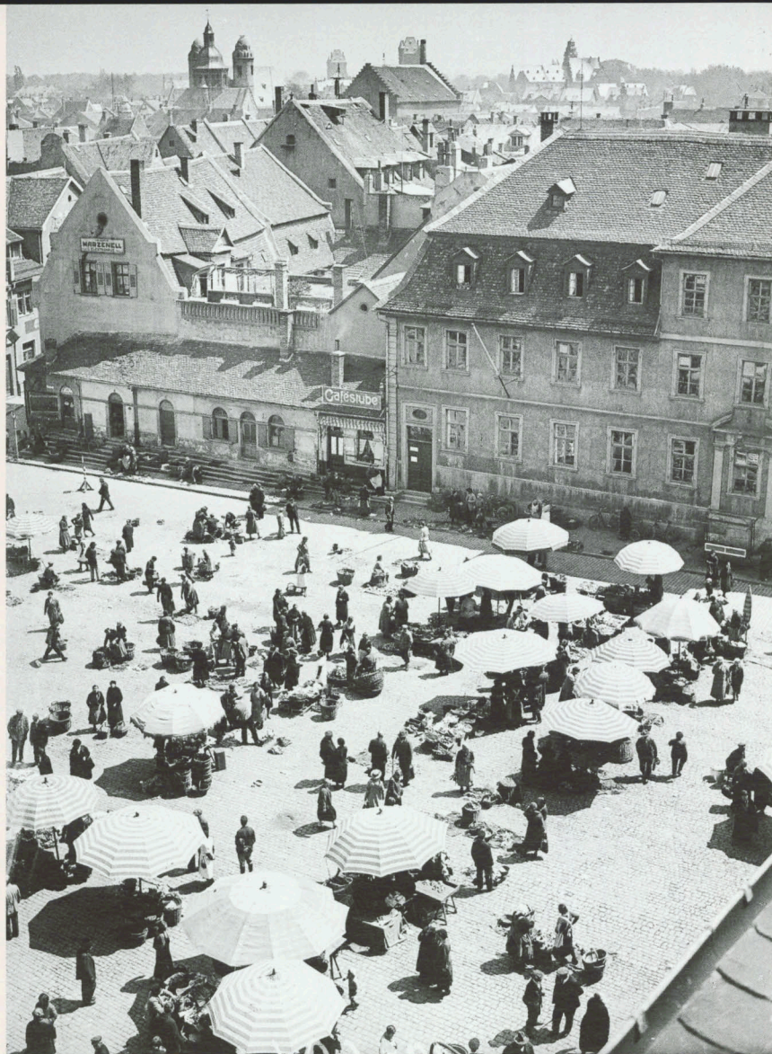
Abb. 55: Blick über den Marktplatz zum Stadtbauamt, um 1930
