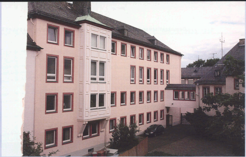
Abb. 83: Blick vom Innenhof des alten Rathausflügels auf den Neubau von 1958
