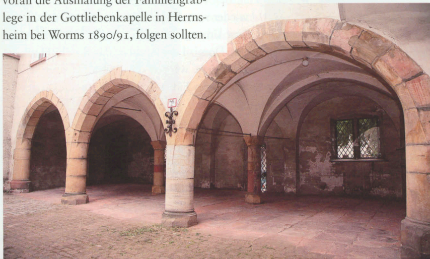
Abb. 35: heutiger Zustand von außen
